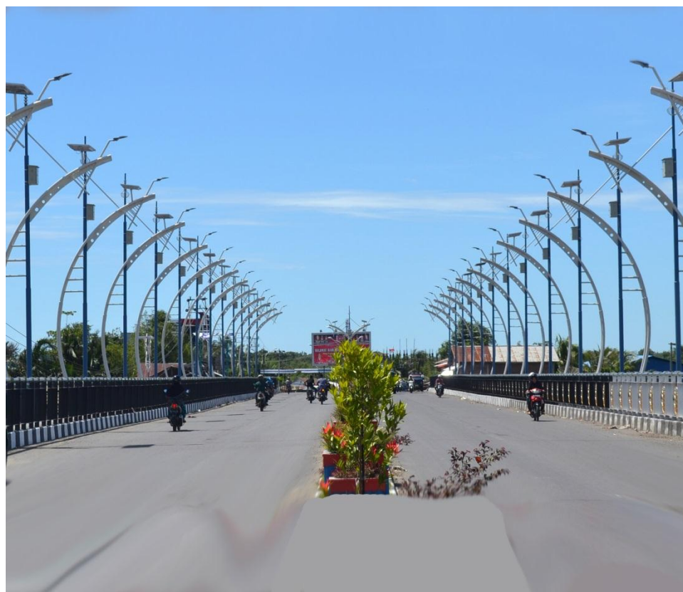
Jalan Nasional Meulaboh – Tapak Tuan ( Jembatan Besi )
